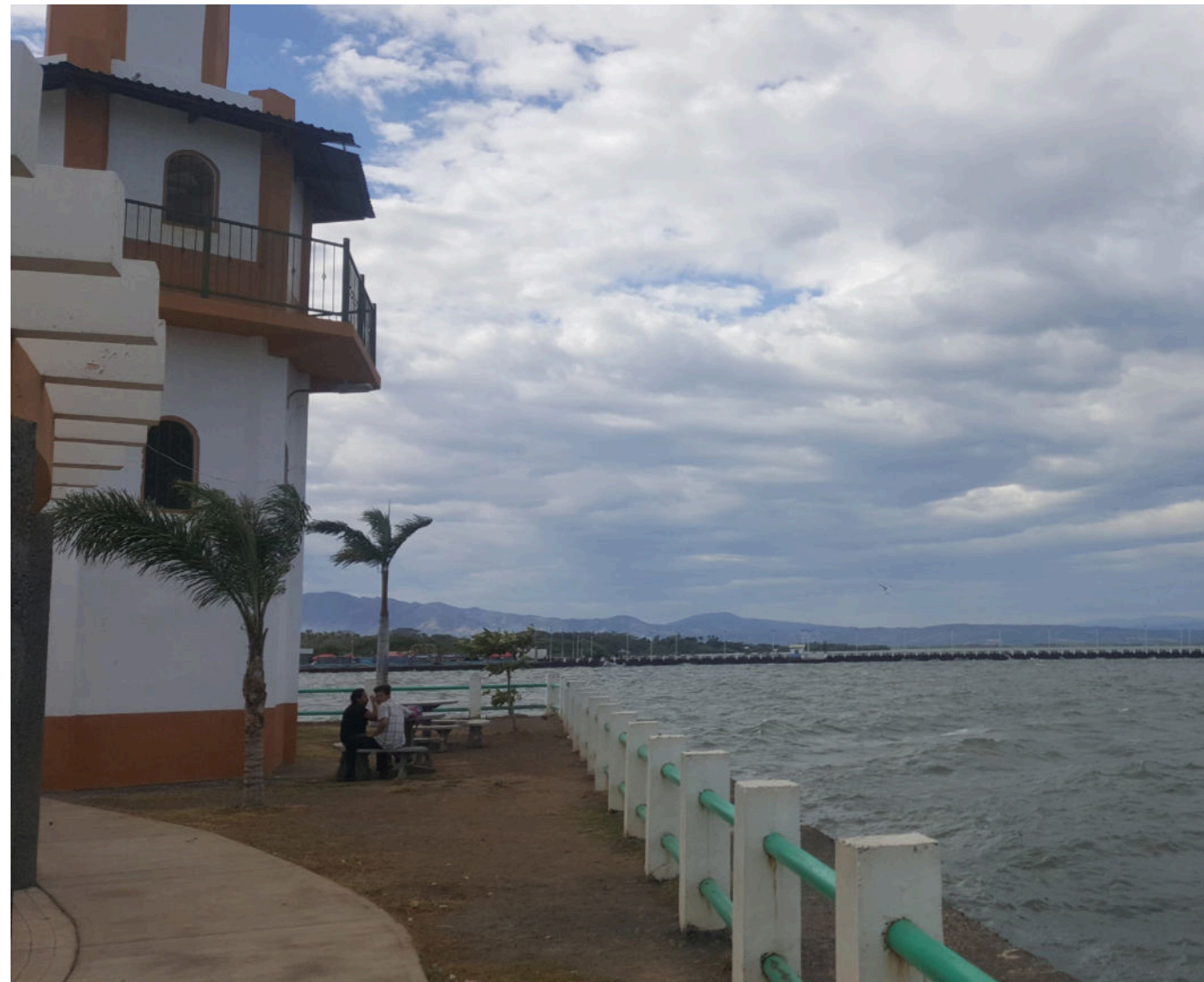
Figura 188. Área de muelle artesanal Los Coquitos con riesgo a inundaciones por marea extraordinaria Fuente: MARN, 2019
