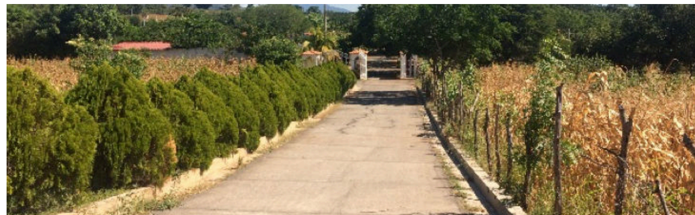
Figura 196. Acceso al sur de lotificación de Intipucá, municipio Intipucá Fuente: MARN, 2019
