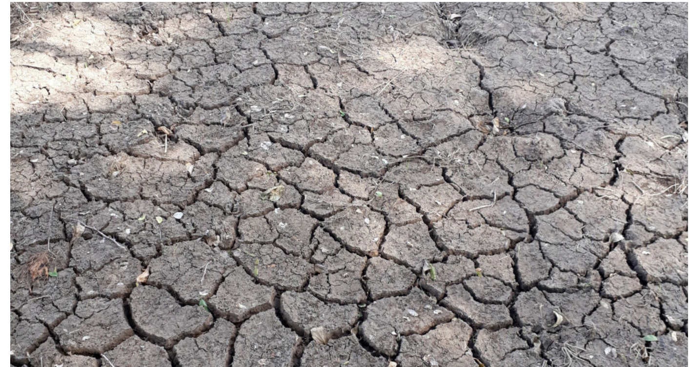
Figura 23. Erosión gravitacional e hídrica causada por inundaciones, zonas aledañas a pantano Fuente: MARN, 2019
