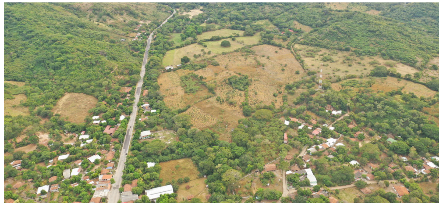
Figura 145. Carretera Panamericana a municipio El Carmen Fuente: MARN, 2019
