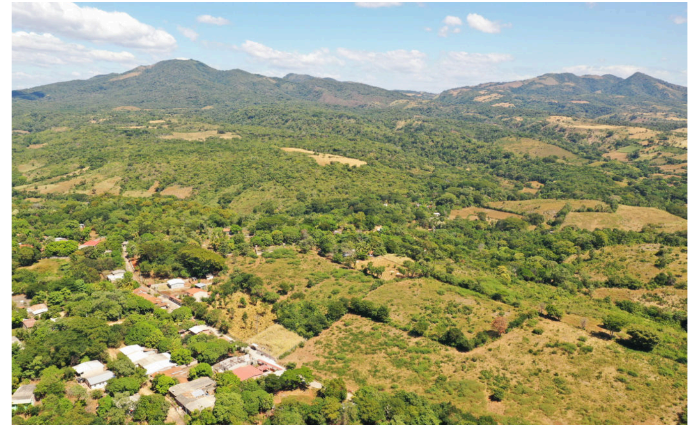
Figura 215. Panorámica de tejido edificado, municipio Intipucá Fuente: MARN, 2019
