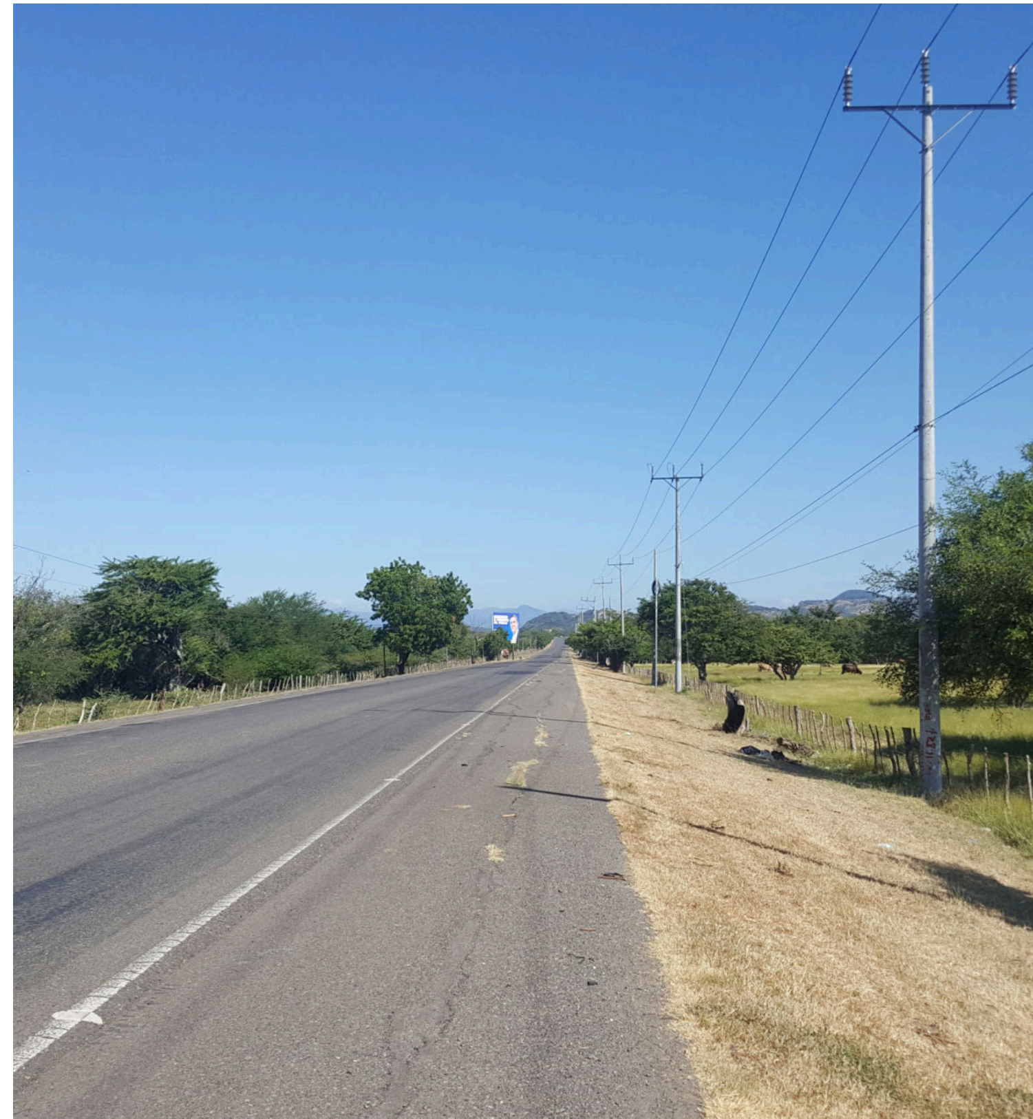
Infraestructura vial, carretera a Pasaquina, MARN 2019
