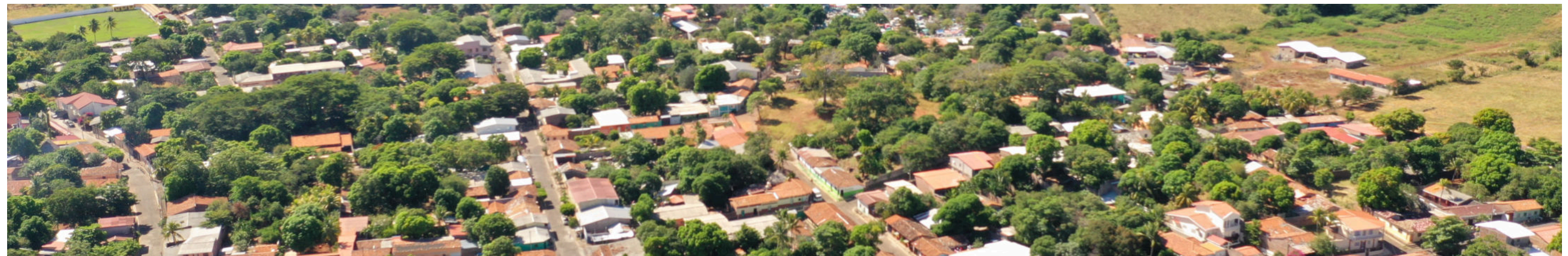
Infraestructura vial, casco urbano del municipio de Intipucá, MARN 2019
