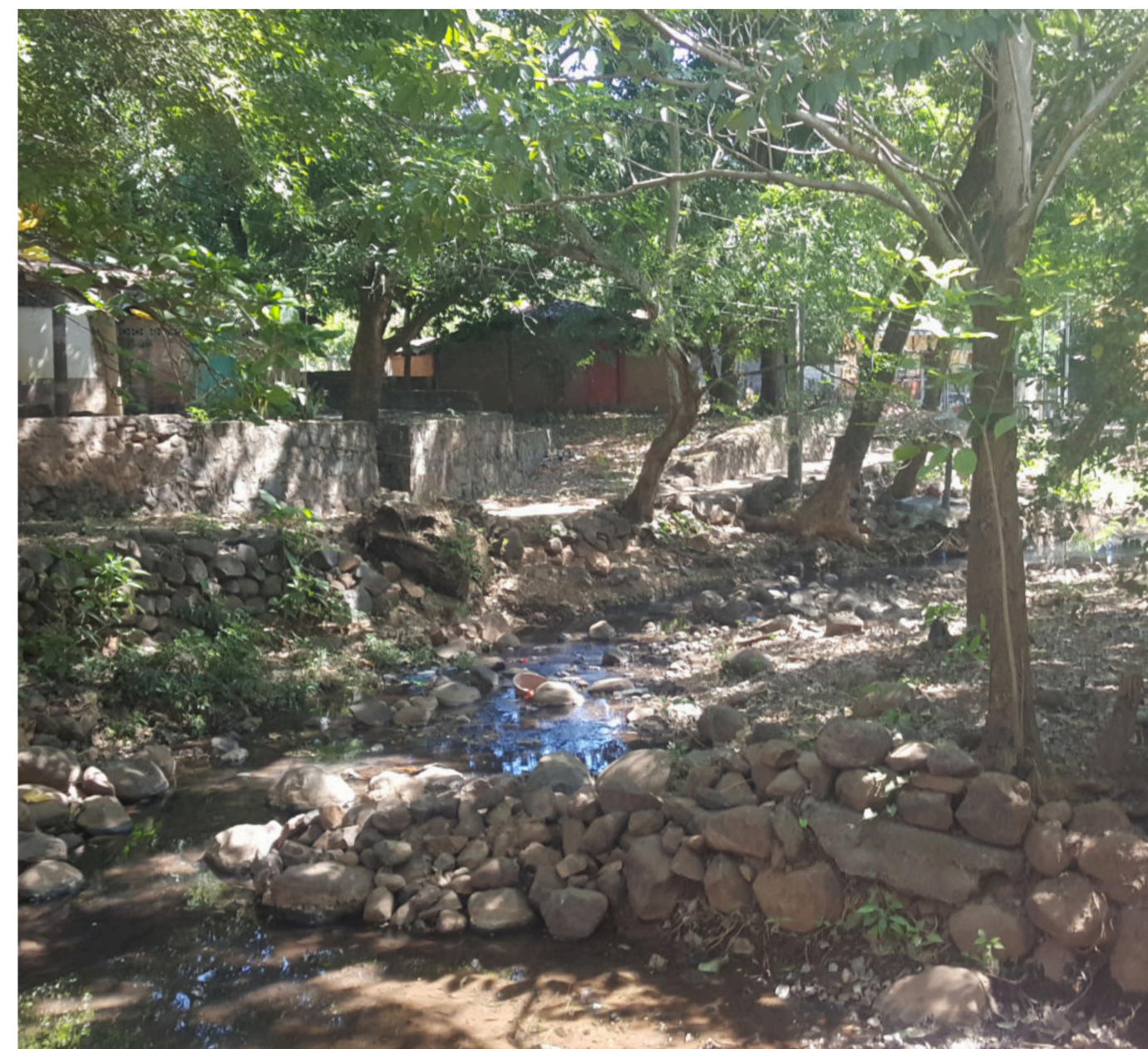
Figura 182. Drenaje natural en áreas de tejido edificado, zona con exposición a amenaza de inundación Fuente: MARN, 2019
