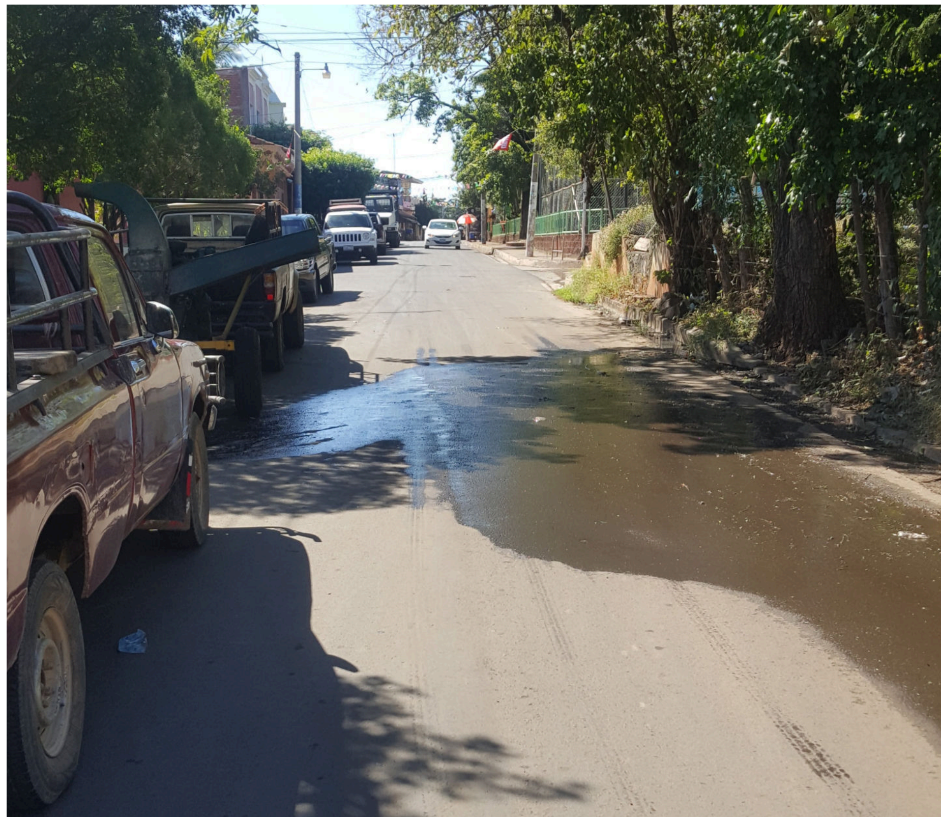
Figura 201. Vías de acceso del casco urbano del municipio y la problemática de descargas de aguas grises a la vía Fuente: MARN, 2019
