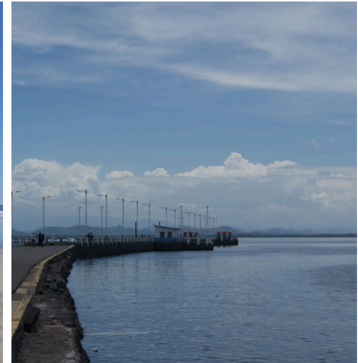
Figura 113. Vista del Muelle los Coquitos, municipio. La Unión Fuente: MARN, 2019
