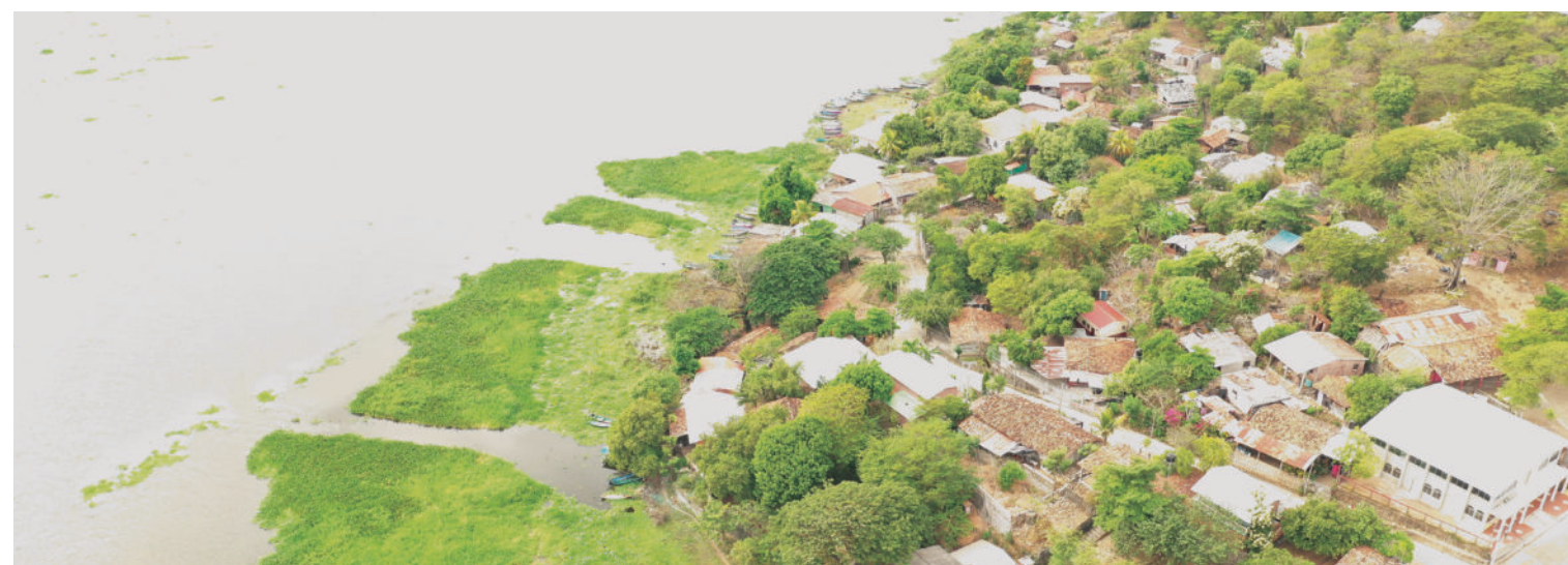
Figura 178. Viviendas alrededor de la laguna de Olomega con riesgo de inundaciones, municipio de El Carmen Fuente: MARN, 2019
