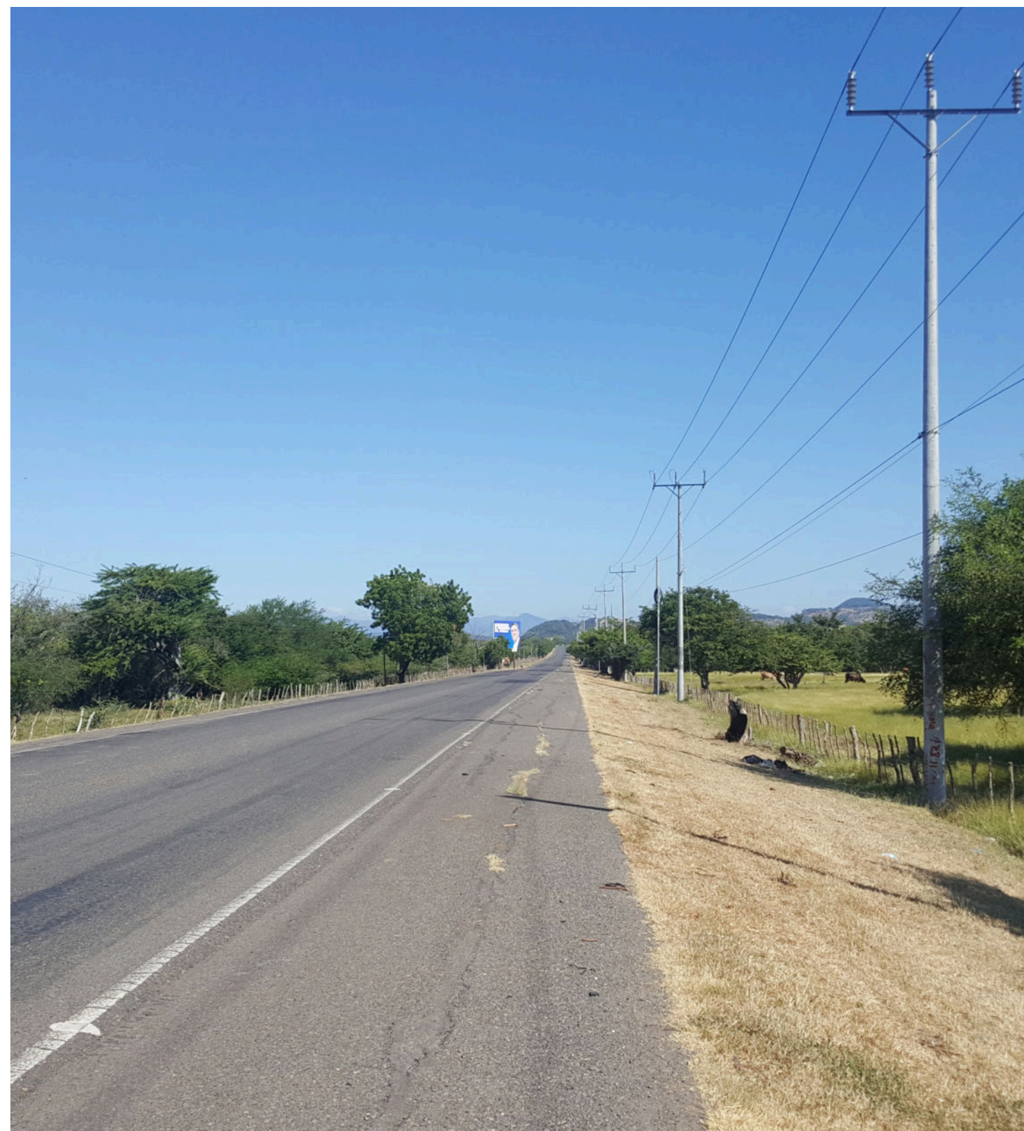
Infraestructura vial, carretera a Pasaquina, MARN 2019
