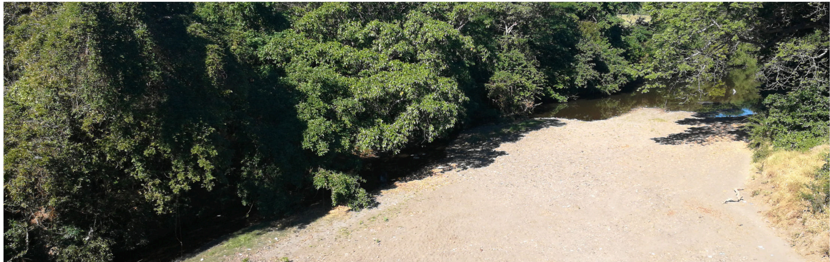
Sedimentación del cauce del río Pasaquina (bajo el puente), municipio Pasaquina, MARN 209
