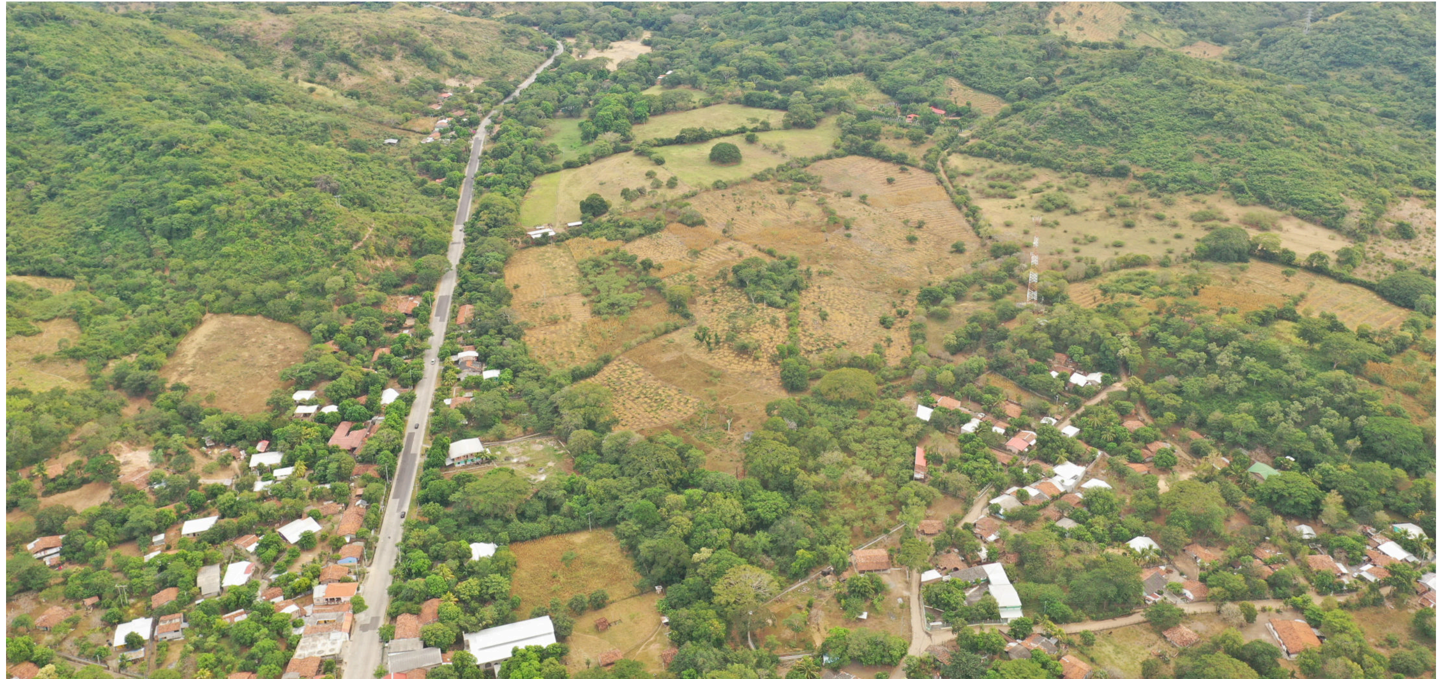
Recorrido de carretera Panamericana en el municipio El Carmen, MARN 2019
