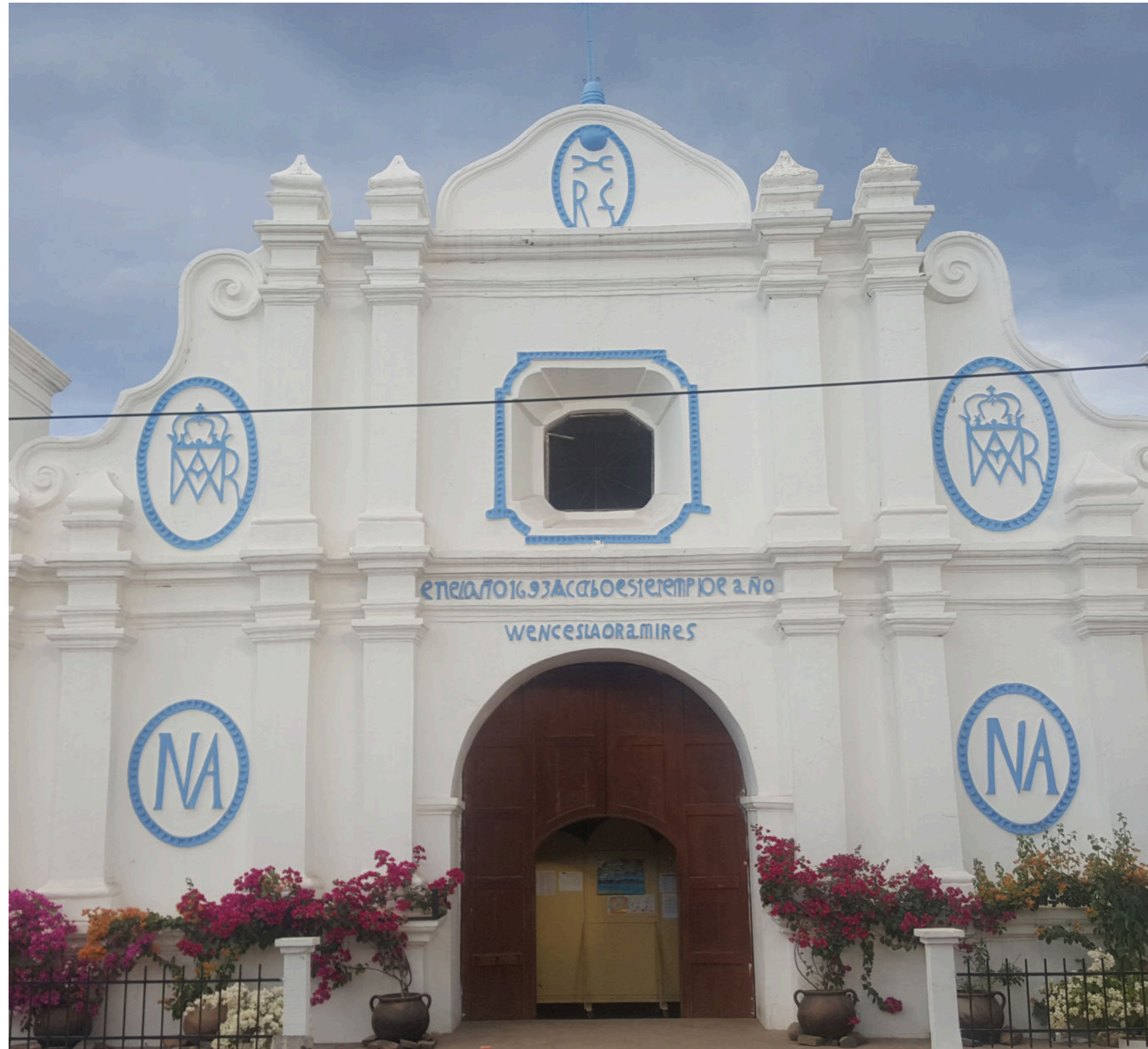
Figura 115. Iglesia Santiago de Conchagua, municipio Conchagua Fuente: MARN, 2019
