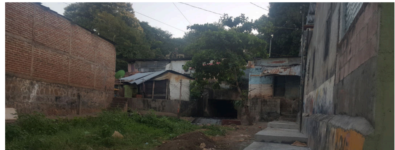
Figura 97. Tejidos edificados expuestos a amenaza por inundaciones Fuente: MARN, 2019
