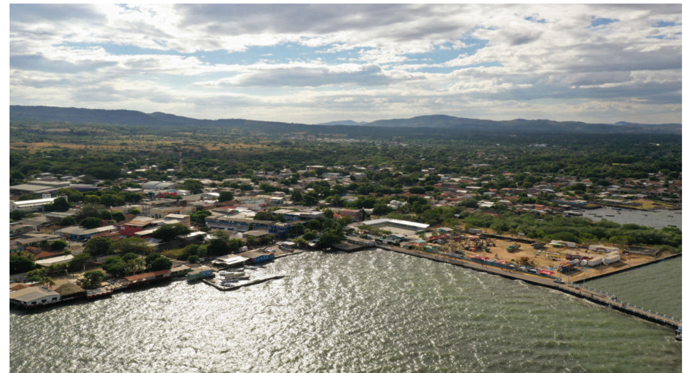
Figura 148. Zona edificada condicionada, muelle municipal de La Unión Fuente: MARN, 2019
